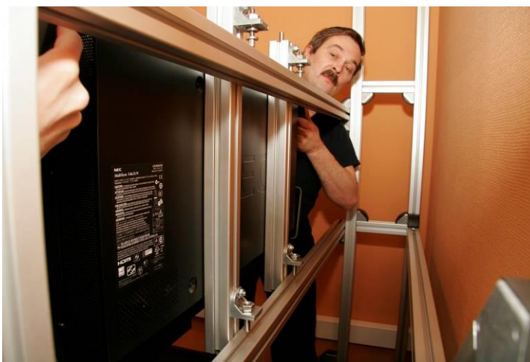
Установка нижней панели
