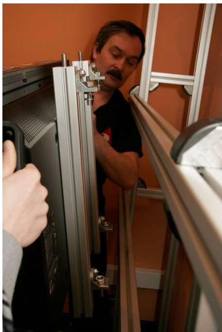
Установка нижней панели
