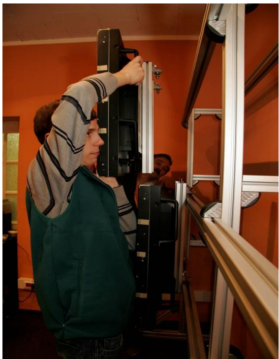
Установка верхней панели
