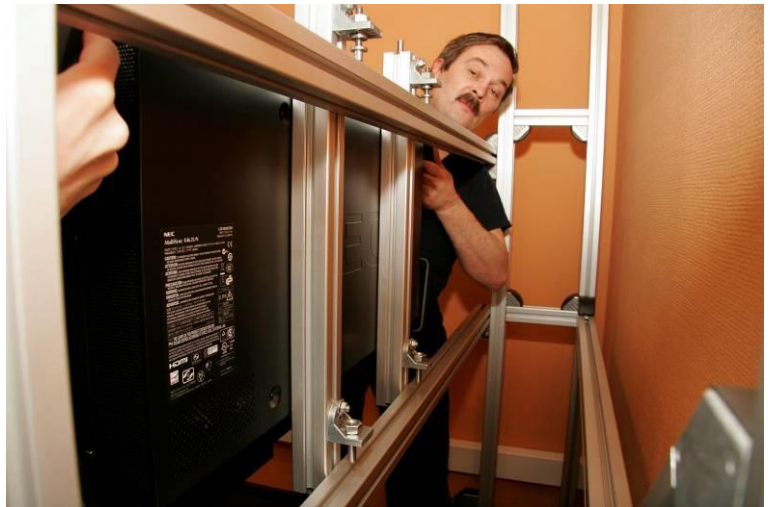
Установка нижней панели
