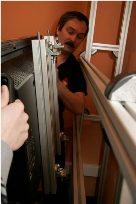
Установка нижней панели
